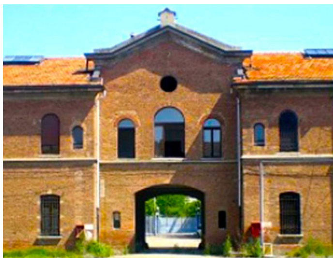
Ingresso del vecchio Arsenale di Pavia ora in ristrutturazione
