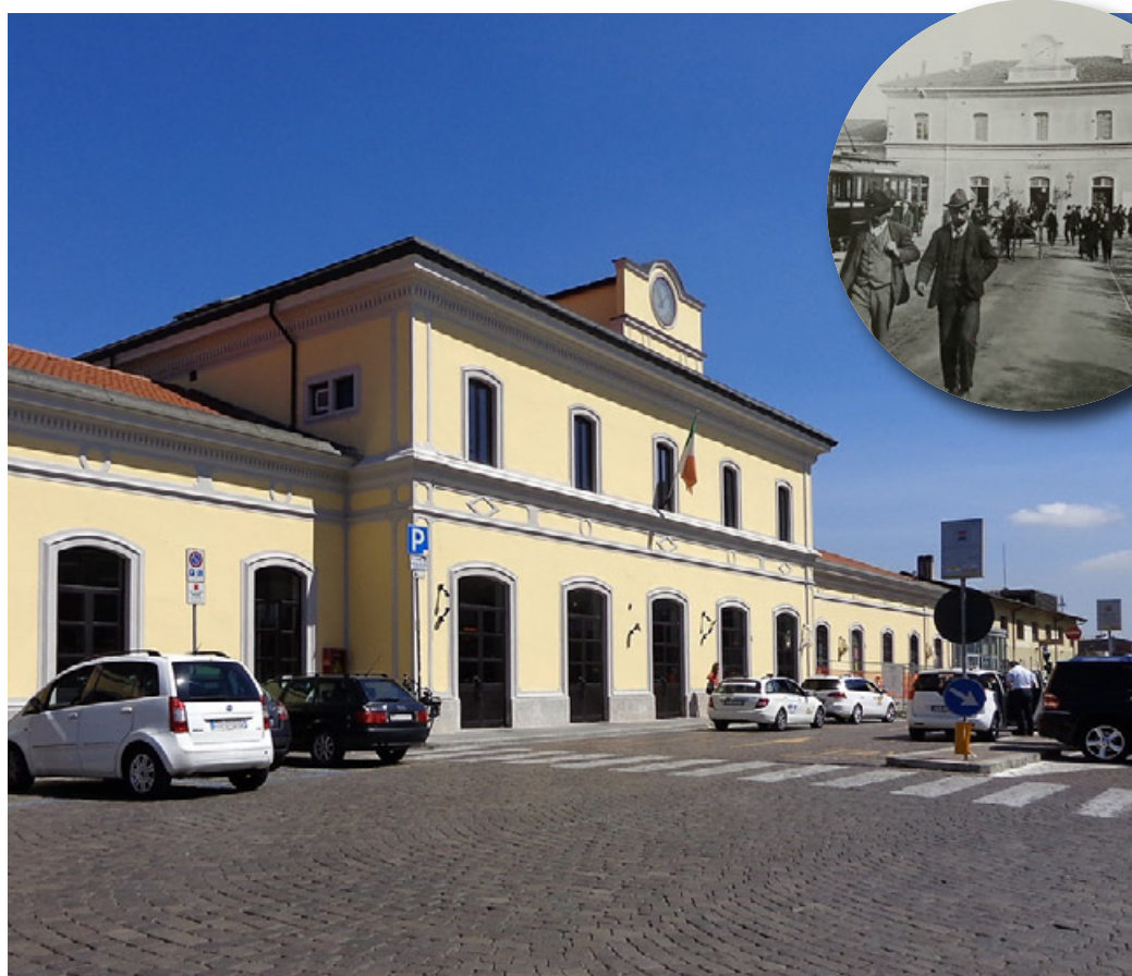
La stazione ferroviaria oggi e, nel tondo, come era nel 1915
