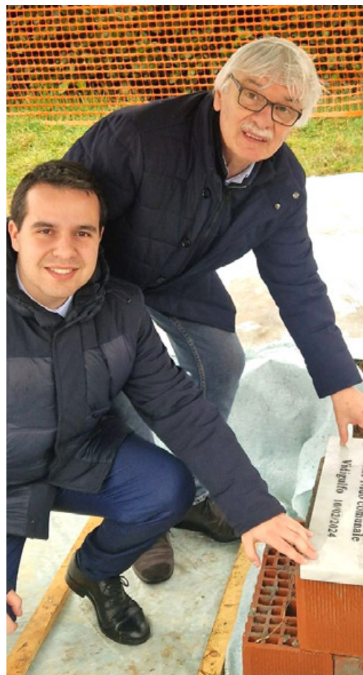
Sindaco e vicesindaco alla posa della prima pietra
