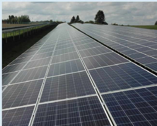
I pannelli fotovoltaici saranno installati sul PalaElachem
