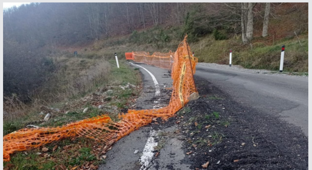
La SP90 interessata dai lavori di ripristino
