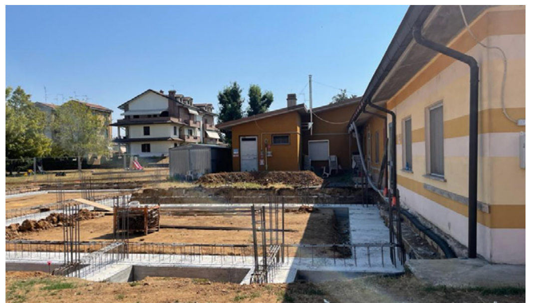
Belgiosioso: aperto il cantiere per la costruzione di una nuova scuola materna
