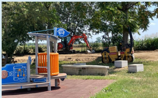
In foto, i lavori a Belgioioso per le nuove strutture sportive
