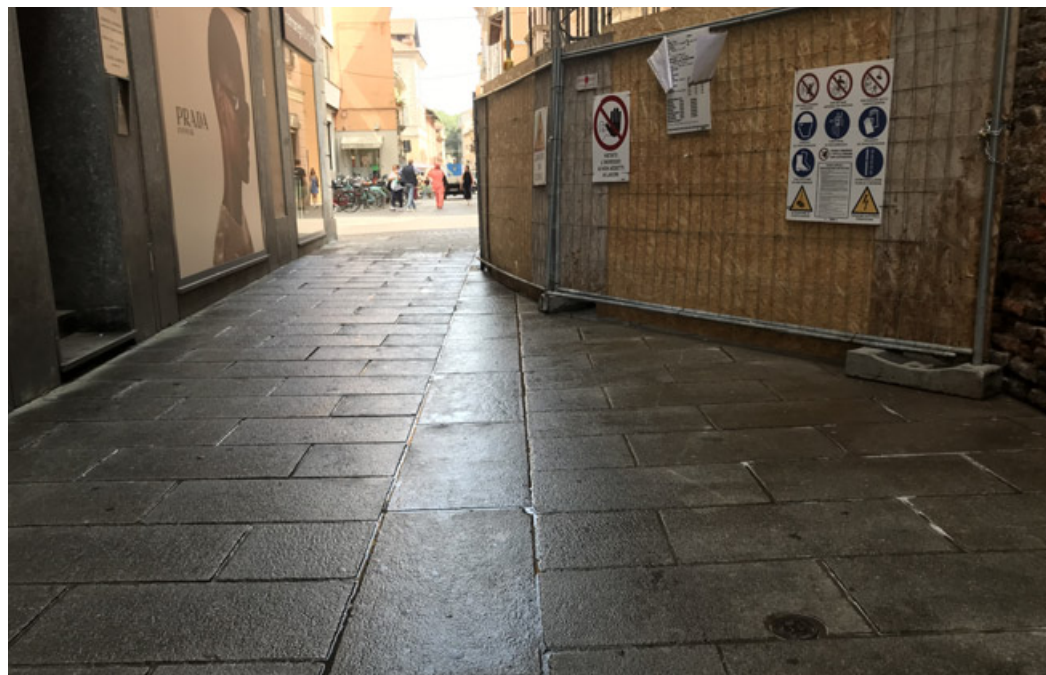
Lavori di bonifica nelle vie del centro di Pavia
